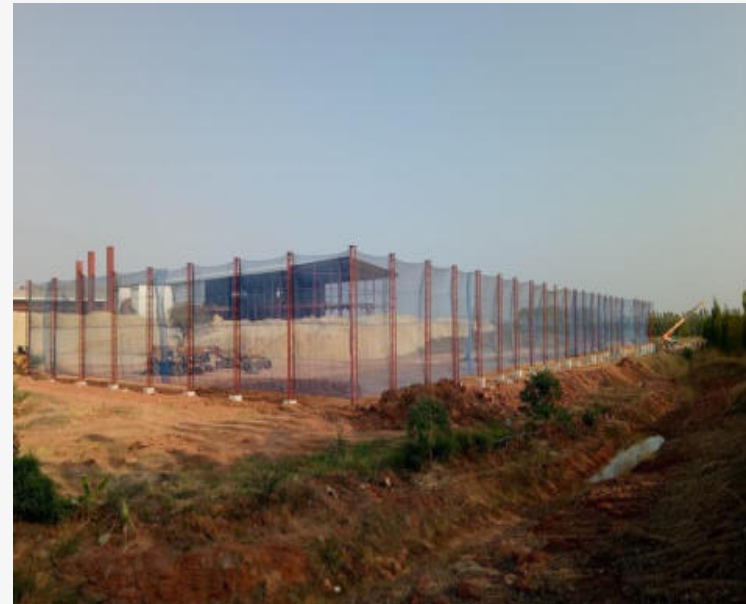
จัดทำโครงเหล็กตาข่ายพลาสติกโพลีเอทิลีนรอบ พื้นที่กองกากอ้อยเพื่อลดการฟุ้งกระจาย
