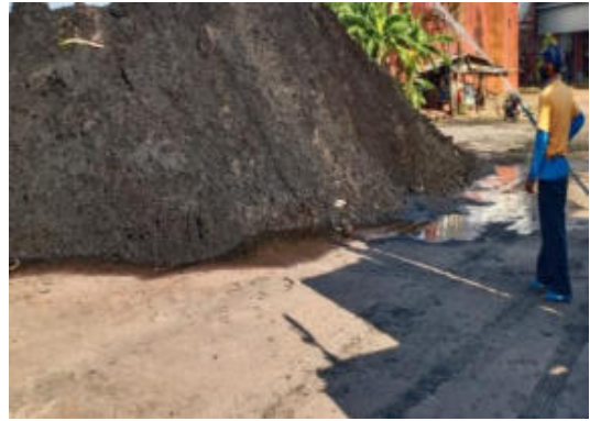
รูปที่ 16 การฉีดพรมน้ำกองเถ้า
