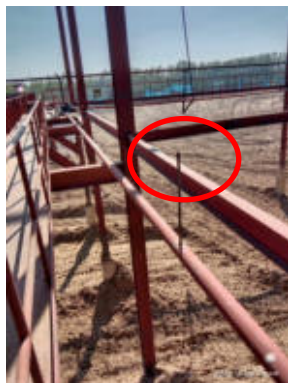
รูปที่ 57 ระบบหัวพ่นน้ำ(Sprinkler) และท่อน้ำดับเพลิงบริเวณรอบกองขานอ้อย
